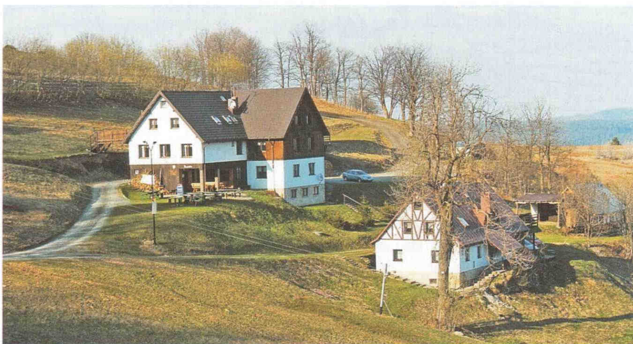
Fot. 4. Remonty i modernizacje zabudowy w charakterze zabudowy sudeckiej – Zieleniec
